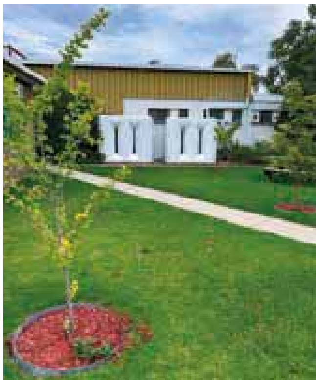
Le site Schneider Electric de Benalla en Australie
